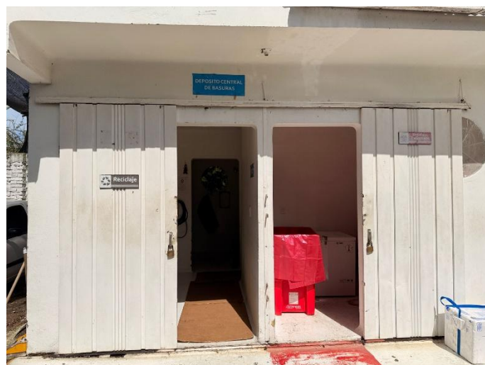
Imagen 2. Unidad Central de Almacenamiento
